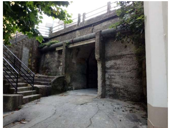
Vista de los servicios grapados al puente
